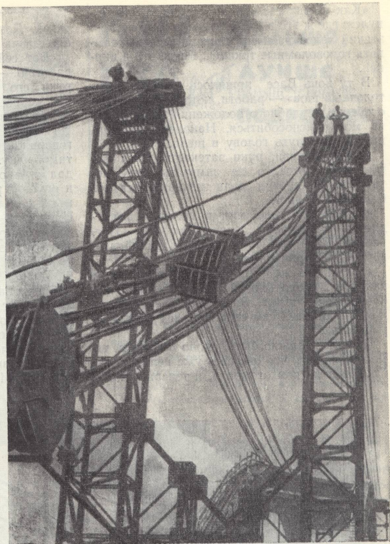
Арка моста весит более пяти тысяч тонн, а длина ее достигает двухсот метров. Чтобы не провисали концы моста, их укрепили на этих конструкциях. Это участок мастера комсомольца Игоря Цариновского.
